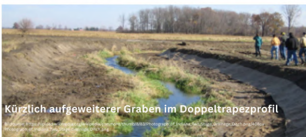
Aufgeweiteter Graben mit Pufferstreifen, Retentionsbecken, flexiblem Aufstauwehr
